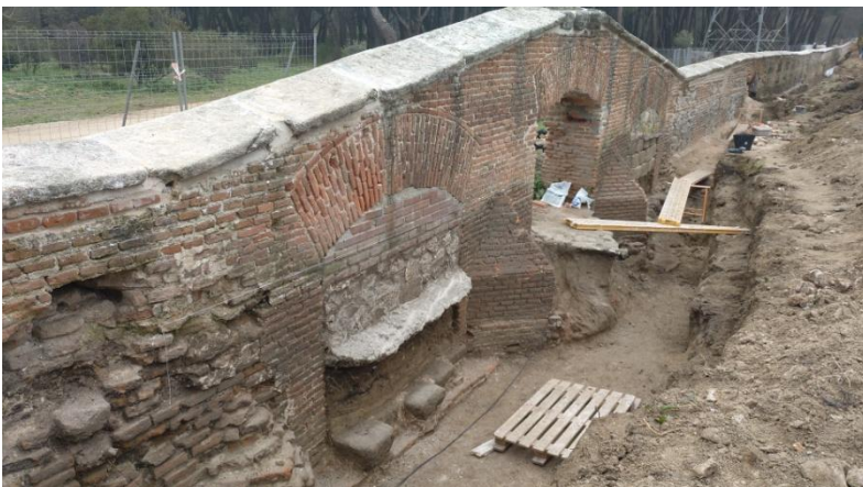
Proceso de las obras de las rejillas del Portugués visualizando sus lechos en piedra berroqueña
