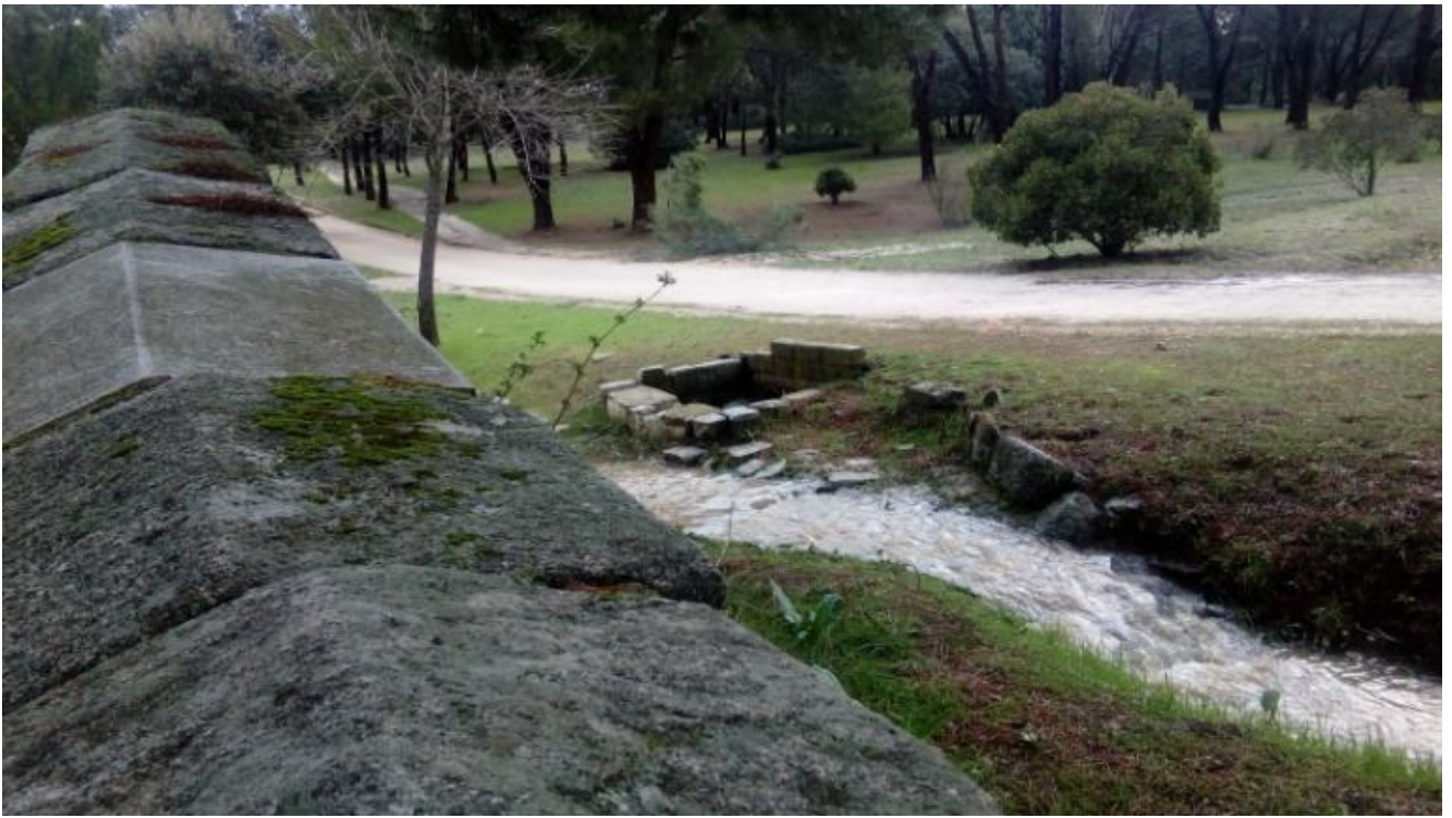
Entrada actual de aguas del arroyo del Portugués a la Casa de Campo siendo llevadas en paralelo al vallado
