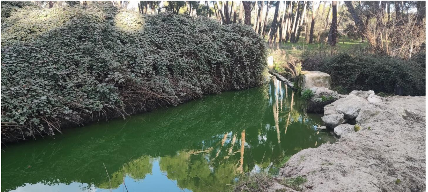
Visualización de la presa y de las zarzas que han crecido sobre los lodos. Tintado de aguas por el mal depurado actual, foto del 2026
