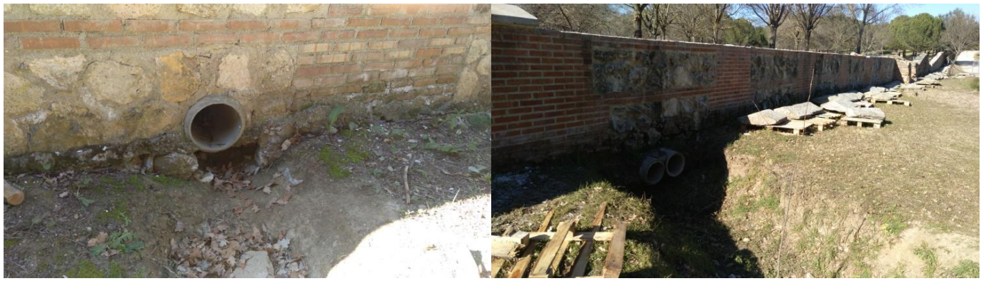
Tubos instalados en la tapia mientras permanecían valladas 12 de las 15 rejas históricas.
