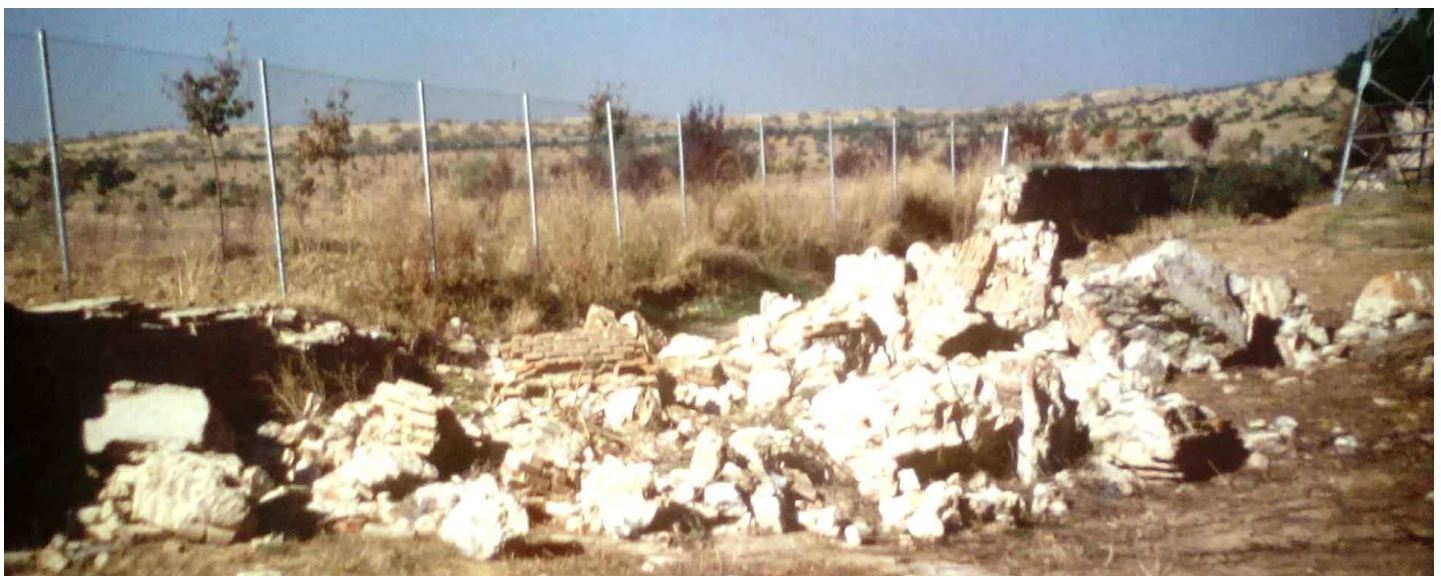
Fotografía del año 1995. La riada se llevó 200 metros de vallado histórico entre los dos arroyos
