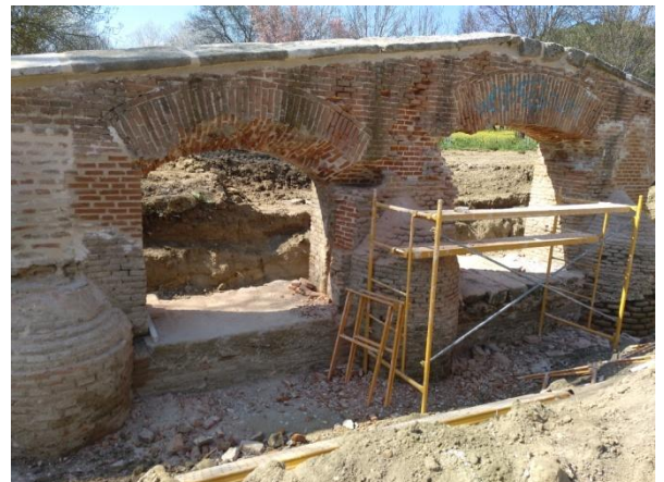
Proceso de las obras de las rejillas del Portugués visualizando sus lechos en piedra berroqueña
