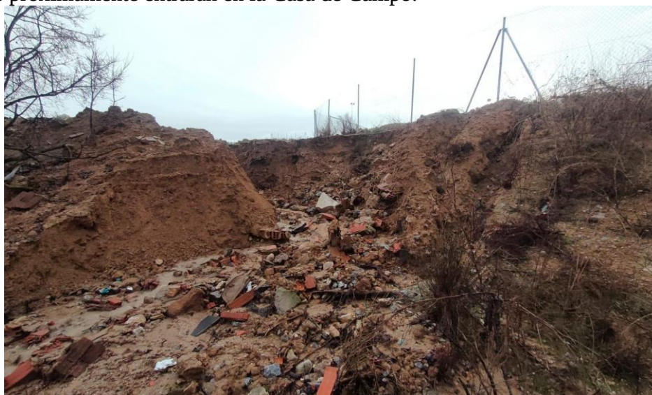
Cárcava producida en el año 2025 / 2026 en la Mina del Portugués consecuencia del movimiento de tierras para su urbanización . Foto 2026
