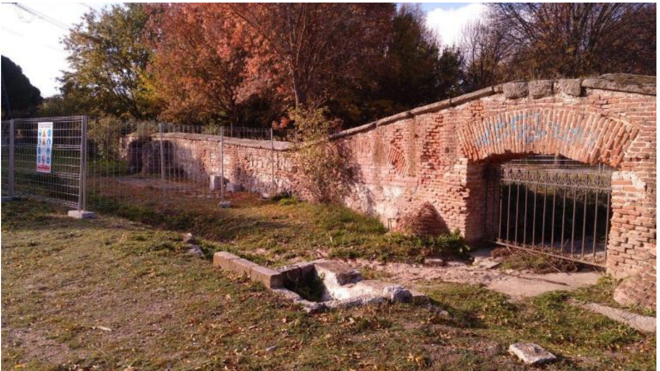
Arqueta de granito para recoger las aguas que atravesaban el camino en la Casa de Campo para ir a desembocar en el Antequina, y desvío de aguas paralelas al vallado
